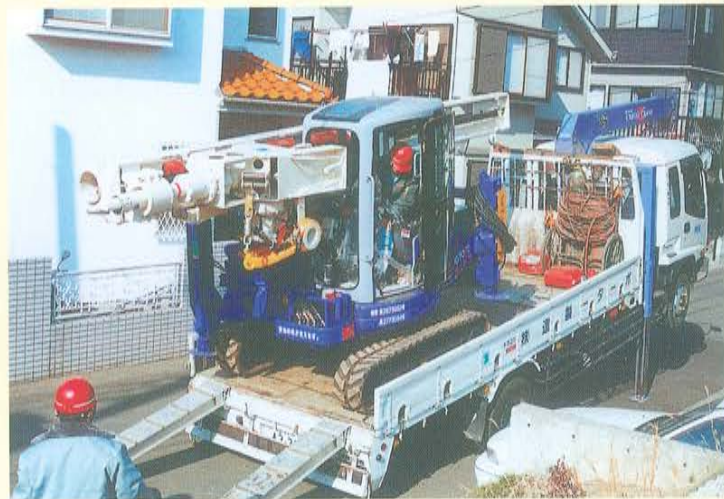
小型回送車（セルフローダー）での搬入作業
