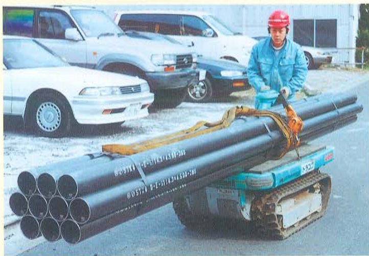
狭小現場への杭搬入専用台車（幅90cm）
